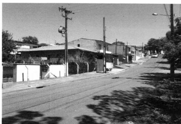
Via de Acesso ao Imóvel
