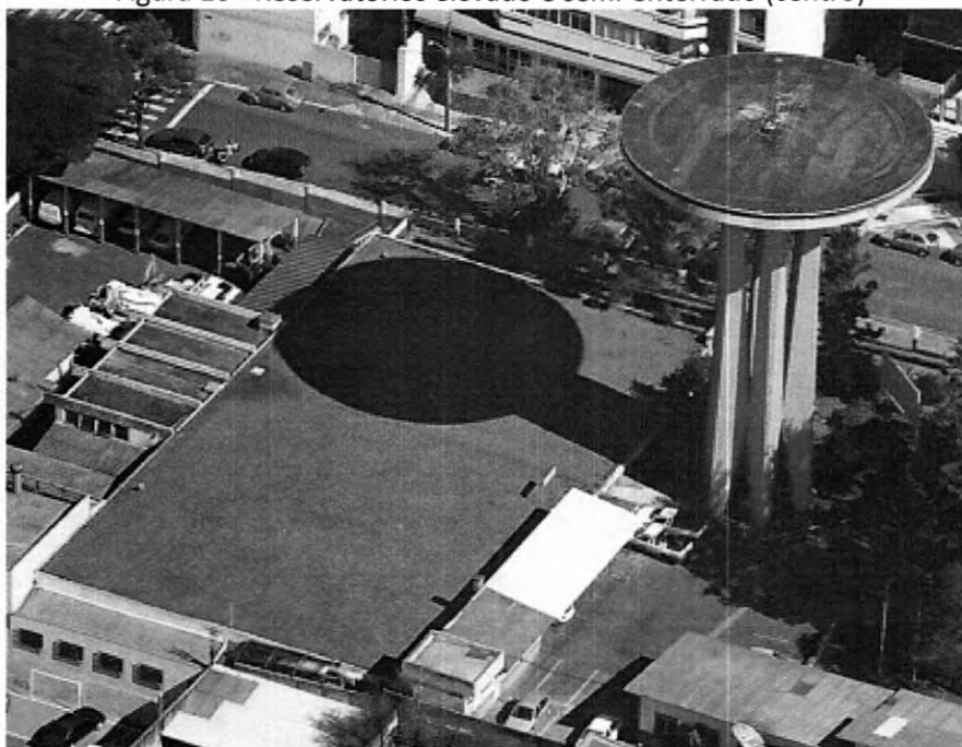
Figura 10 - Reservatórios elevado e semi-enterrado (centro)
